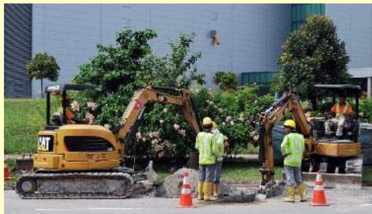
Cat 304正在进行道路挖掘工程，为未来管道铺设做好准备
