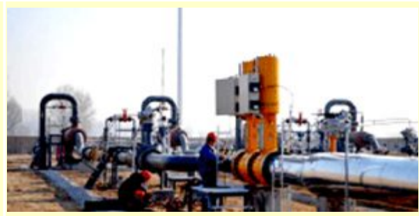
NGG工地实景图
