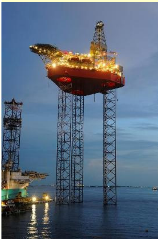
“West Callisto”号钻井平台将是第 32 座投入使用的 KFELS B 级自升式钻井平台。
